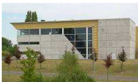
Unité de désodorisation
