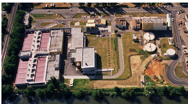
Station d'épuration de la Chauvinière
