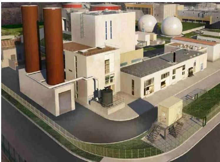
Avril 2019 a vu le démarrage des travaux de méthanisation qui ont pour but de transformer les boues d'épuration issues des eaux usées en biogaz lequel sera injecté dans les réseaux. Ainsi les implantations d'un digesteur, d'un gazomètre et de l'unité de traitement des eaux chargées issues de la digestion (traitement des retours) ont commencé.
